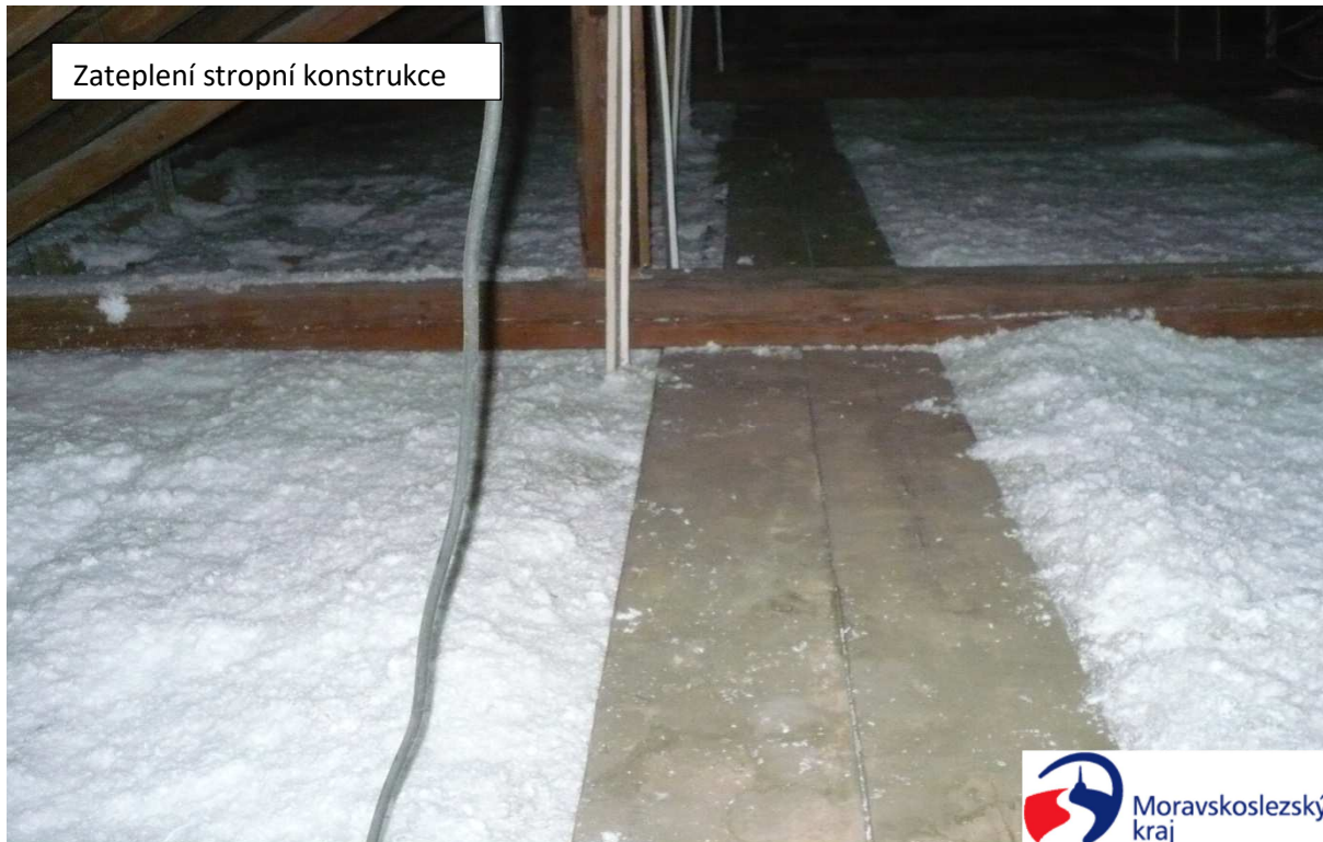
Zateplení stropní konstrukce
